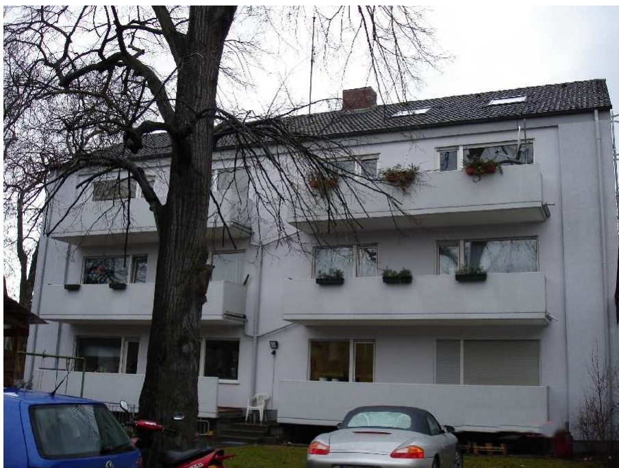
Bild 4: Rückansicht des Wohnhauses aus östlicher Richtung
