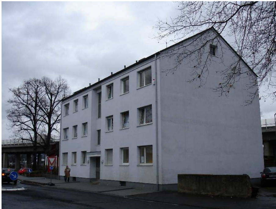
Bild 3: Straßen- und Giebelansicht des Wohnhauses aus südlicher Richtung
