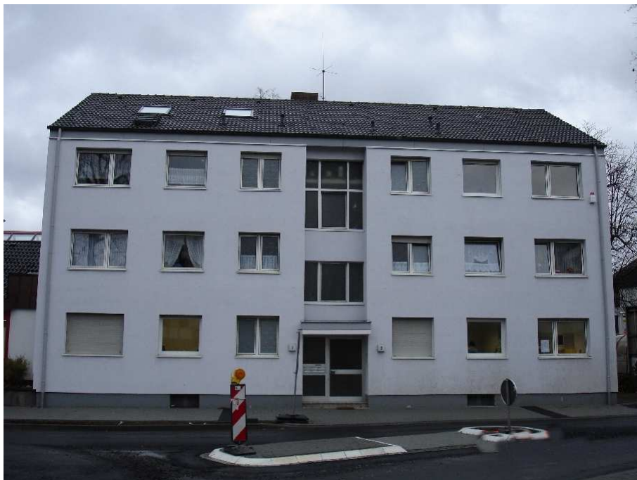
Bild 2: Straßenansicht des Wohnhauses aus westlicher Richtung
