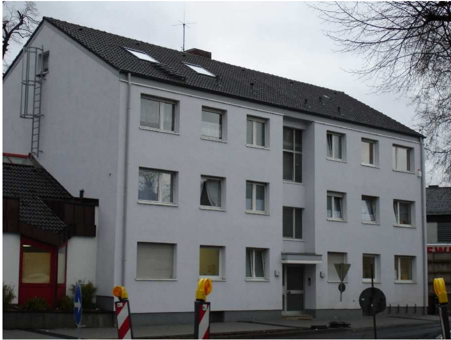
Bild 1: Straßen- und tlw. Giebelansicht des Wohnhauses aus nordwestlicher Richtung
